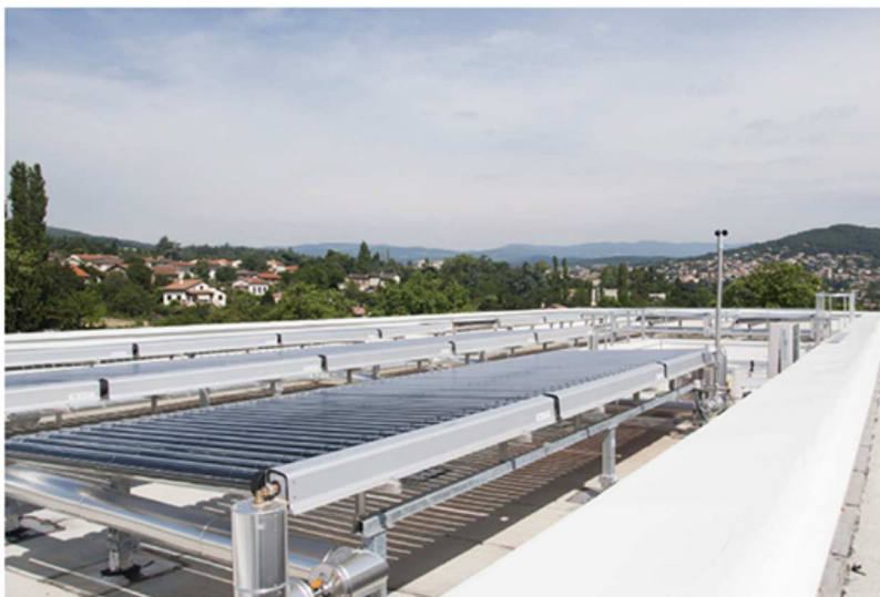
Afin de réduire au maximum ses besoins en énergie et de respecter l'environnement, Aquavaure possède, notamment, des panneaux solaires pour chauffer l'eau des douches, une isolation de l'enveloppe plus importante du bâtiment pour garder la chaleur ou encore une récupération des calories provenant des eaux grises (eaux usées des douches, évier...).
